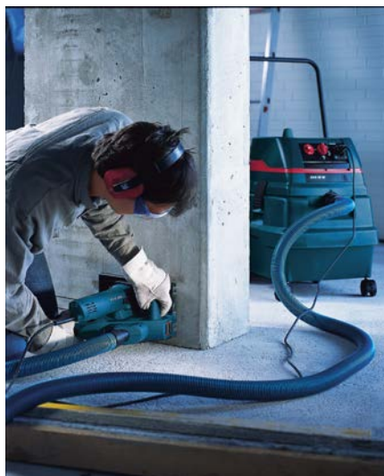
Abb. 22 Mauernutfräse mit Staubabsaugung
