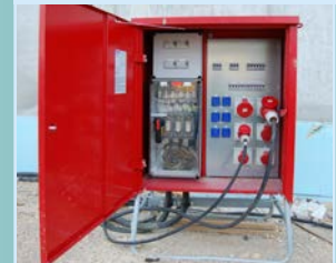
Baustromverteilerschrank
